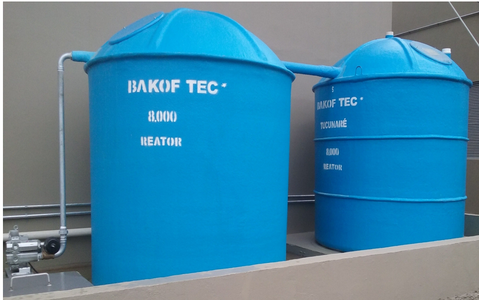
Figura 1. Sistema anaeróbio/aeróbio para atender 8.000 L/dia em tanques verticais.
