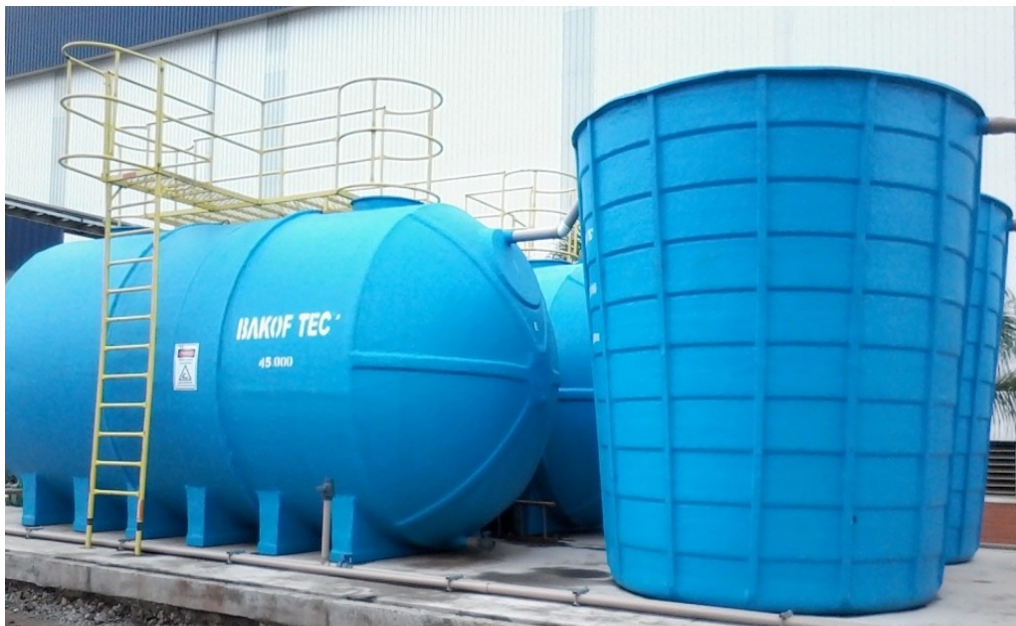
Figura 2. Sistema anaeróbio/aeróbio para atender 90.000 L/dia em tanques verticais (anaeróbio) e horizontais (aeróbio).
